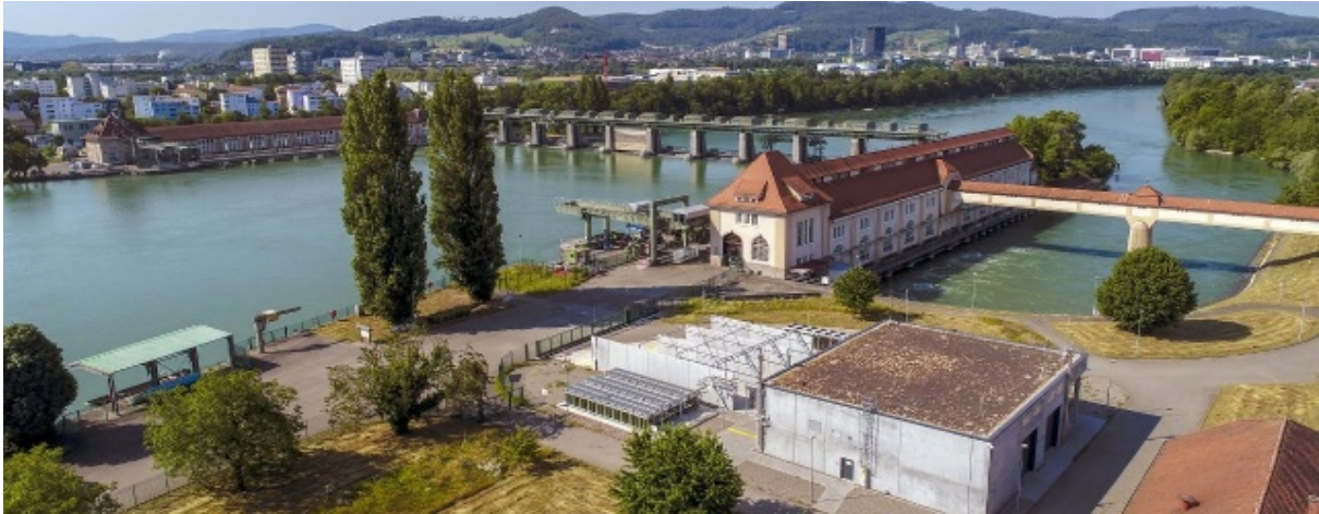
Abbildung 2: Power-to-Gas-Anlage (im Vordergrund) Quelle: Energiedienst
